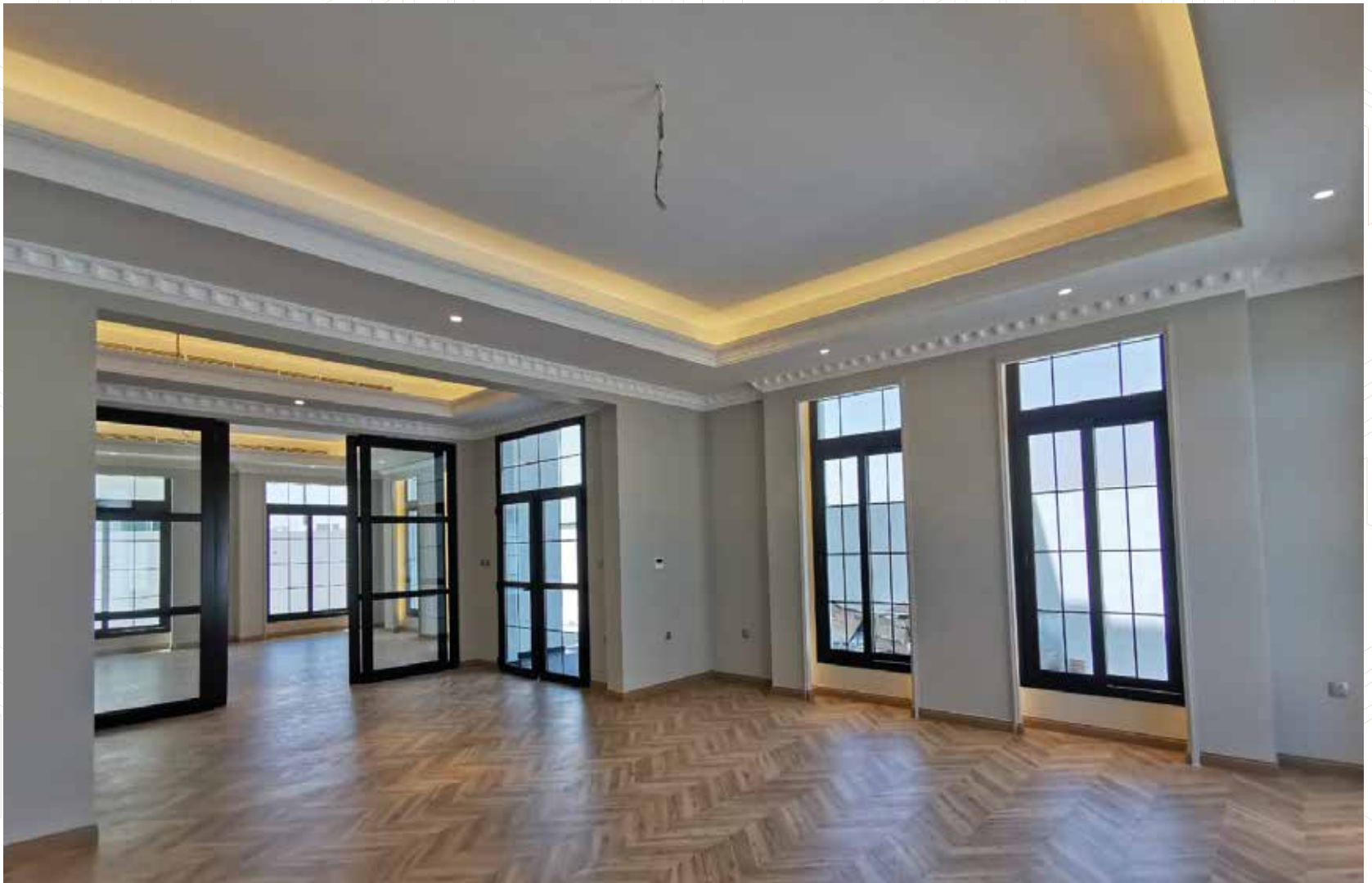
Project : 6 Villa Scope : Construction and Finishing Area : Nueija
