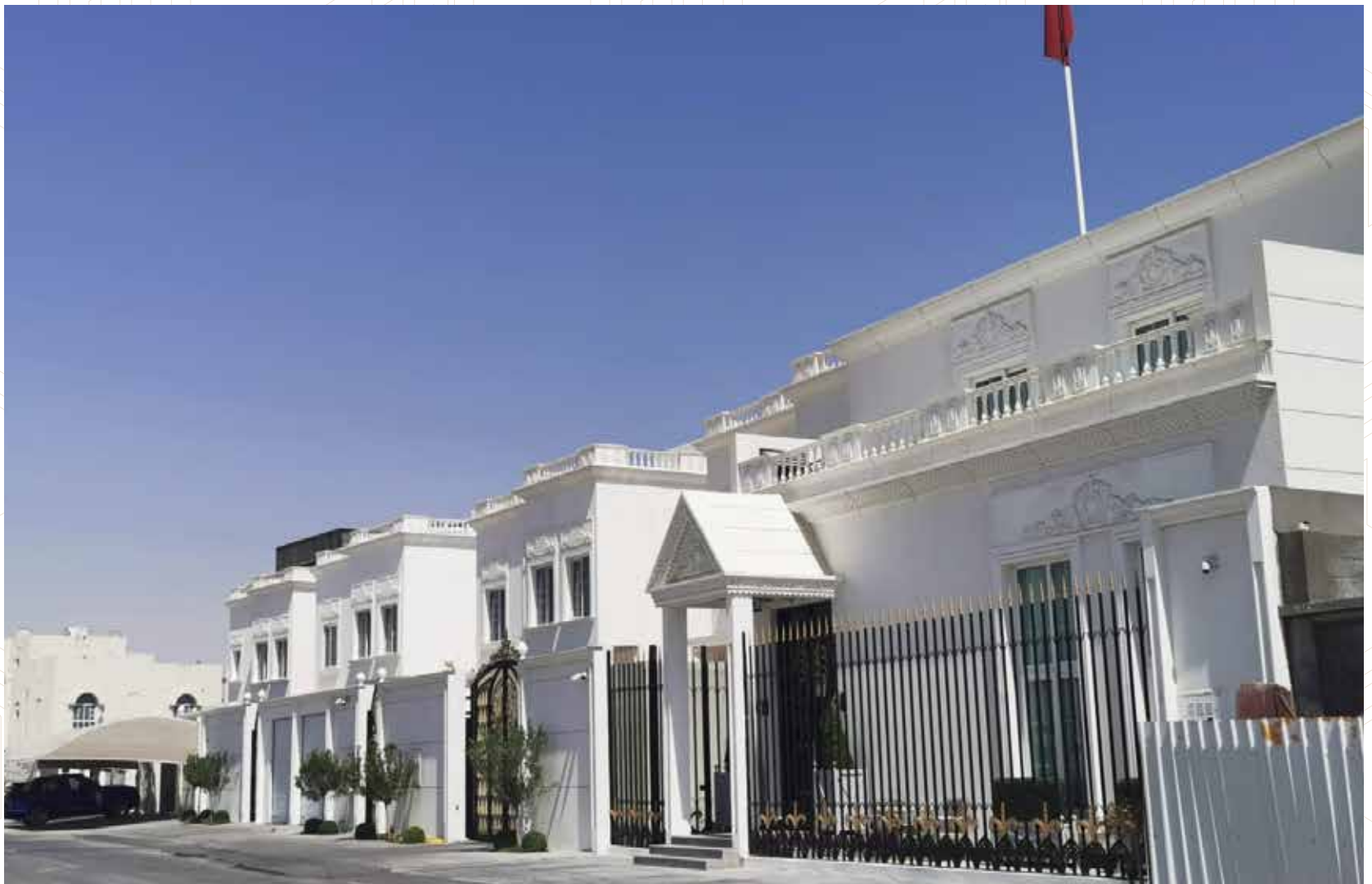
Project : 4 Villa Scope : Construction and Finishing Area : Nueija
